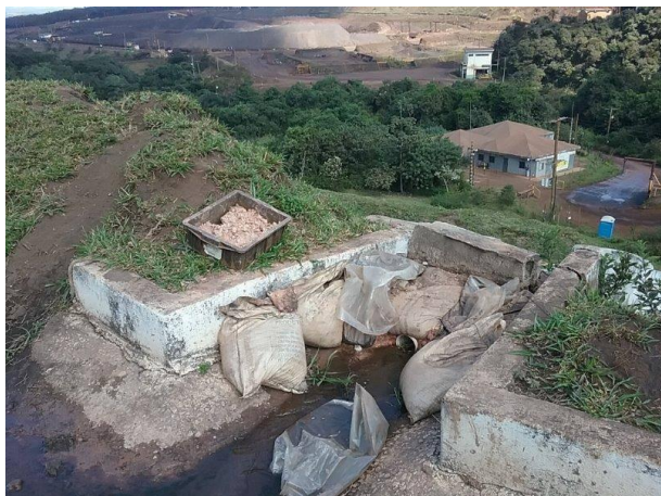
SACARIA NA ENTRADA DA DESCIDA DA CANALETA, OBSTRUINDO PARCIALMETE A PASSAGEM DE AGUA.
