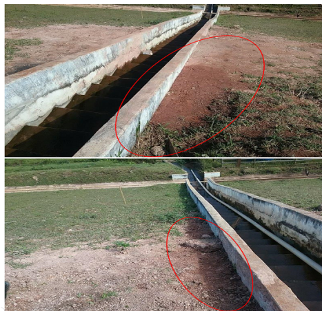
Umidade identificada em ambos os lados da canaleta de drenagem.
